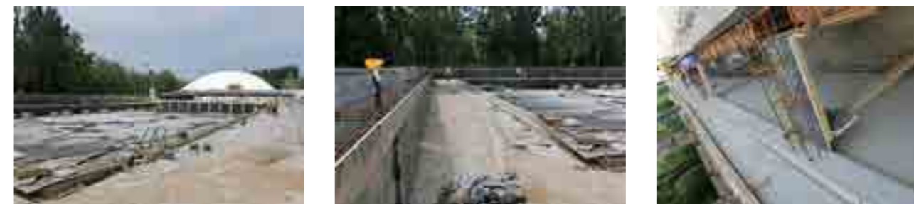
北京私立汇佳学校游泳馆建设现场
