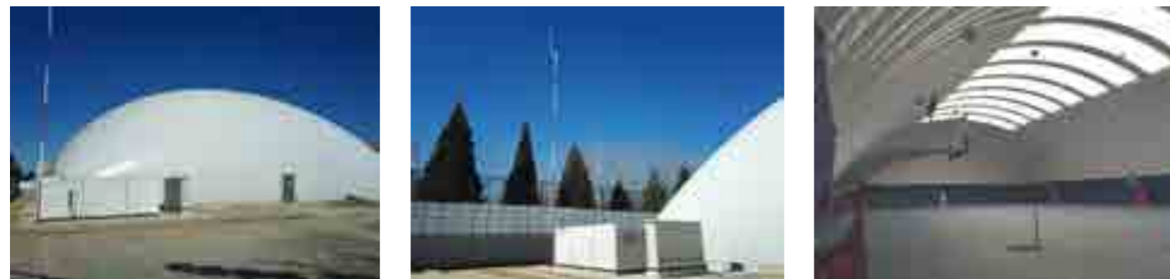
德威英国国际学校综合馆建设现场
